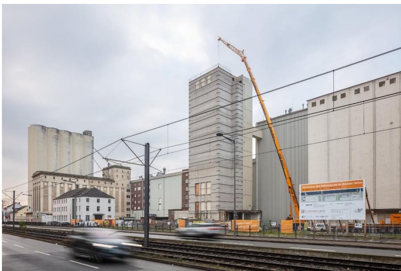
Mühlen im Deutzer Hafen, Teilansicht, Vorbereitung Rückbau Mehlverladesilo
